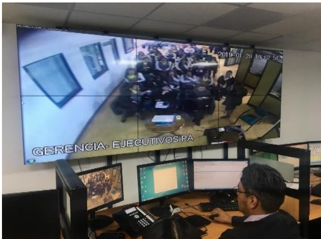
CENTROS DE MONITOREO SISTEMAS DE SEGURIDAD
