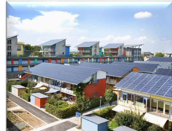
Viviendas sostenibles alimentadas mediante energía solar fotovoltaica en el barrio solar de Vauban (Friburgo, Alemania)
