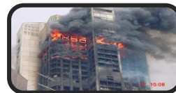
Daños a activos físicos
