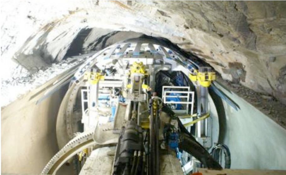
Excavación del Túnel Trasandino
