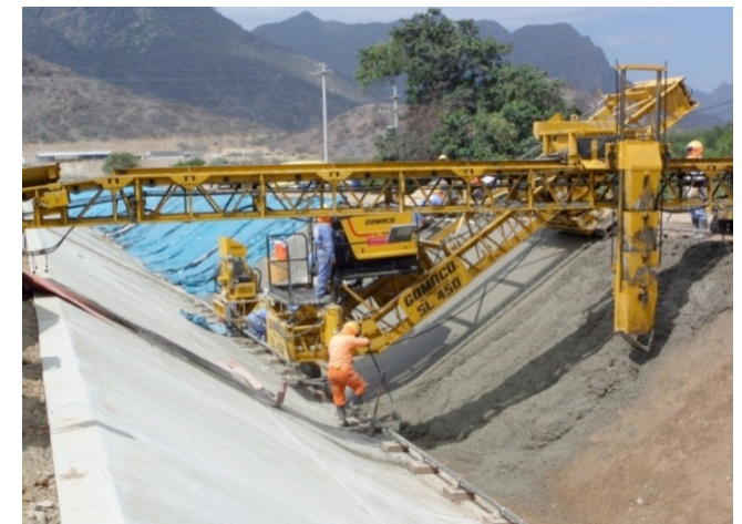
Construcción de canal trapezoidal
